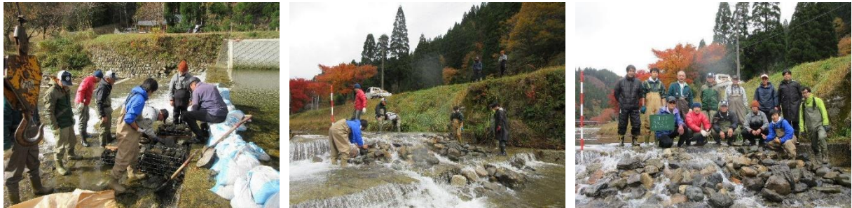
図6 石積み式簡易魚道の設置作業の状況
