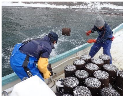
SF ブロック投入
