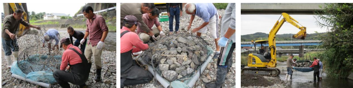
図5 石倉の設置作業
