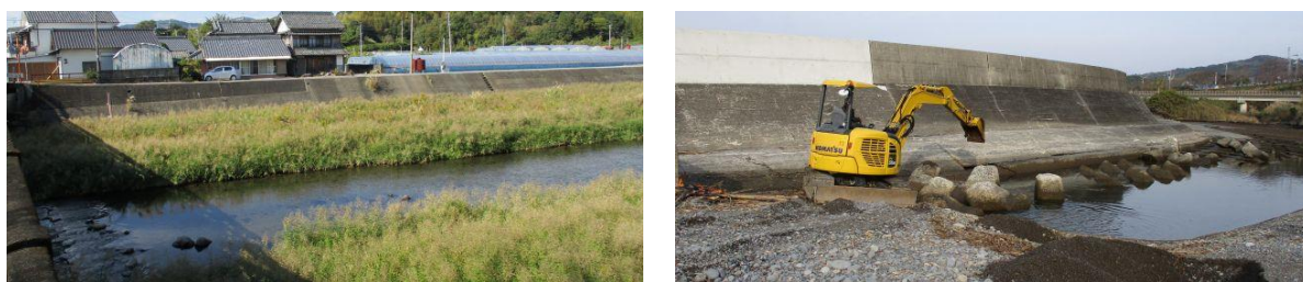
図3 ヨシの大量繁茂による河岸の陸地化および河口閉塞の状況
