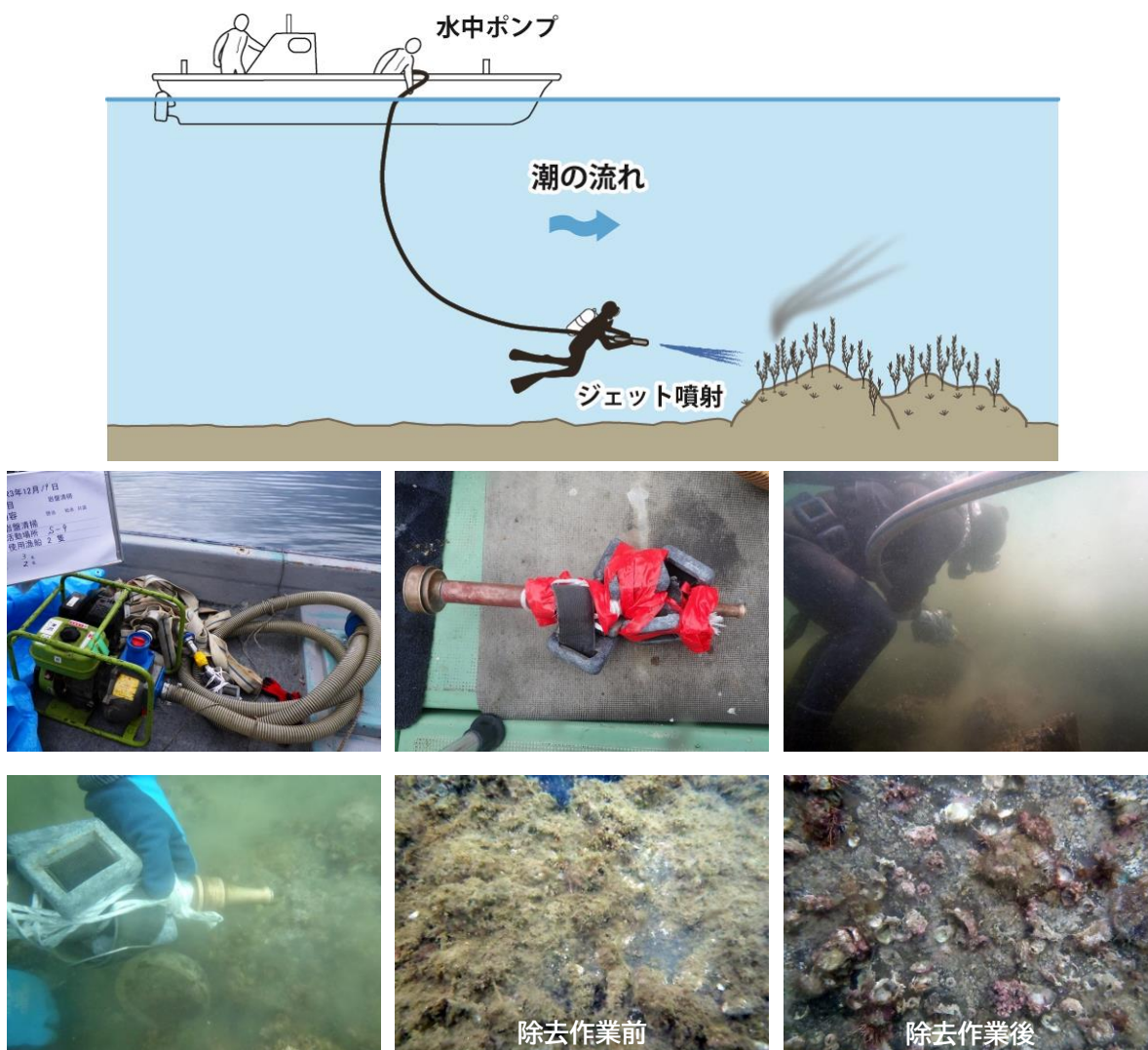
図8 浮泥の除去作業等
