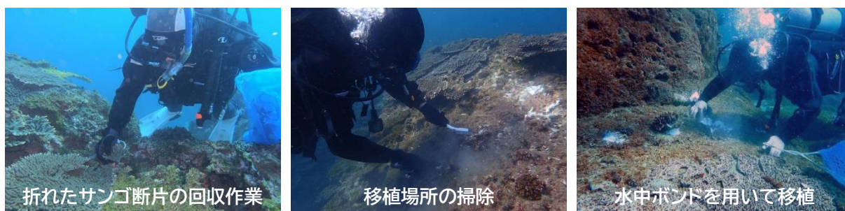
図5 サンゴ移植の作業状況
