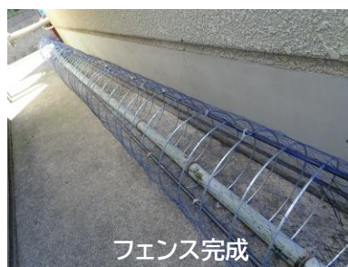
枠作り(輪っかを鉄筋に固定)
