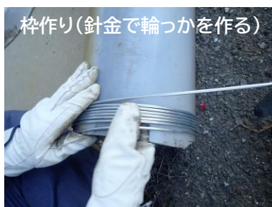
枠作り(輪っかを鉄筋に固定)
