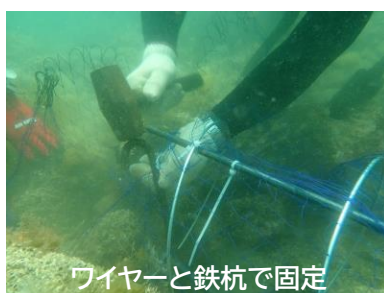
図 7 考案したウニフェンスの製作・設置方法等
