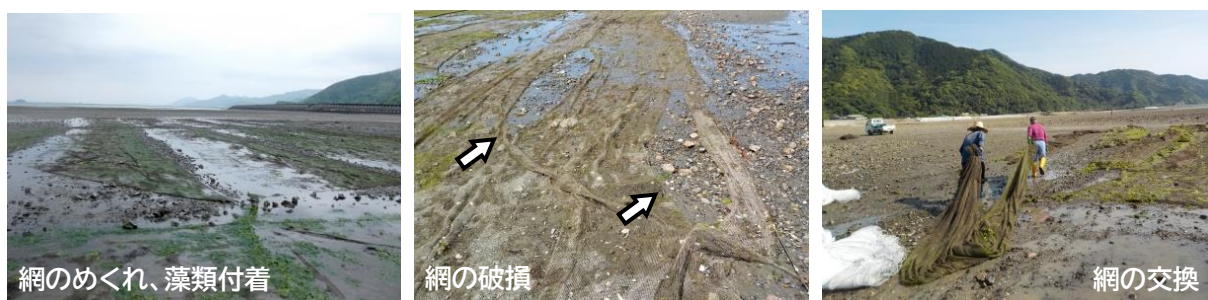
図8 被覆網のメンテナンス作業状況
