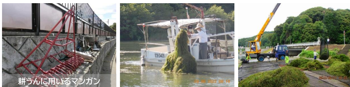
図4 水草等の除去・底質攪拌を目的とする耕うん作業の状況
