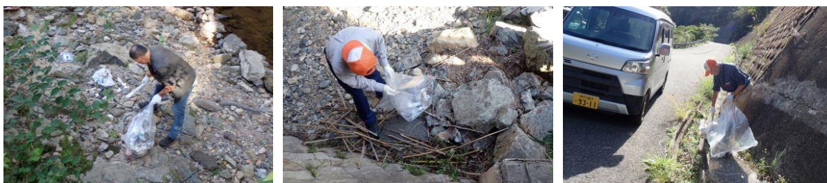
図4 流木・ゴミの除去作業
