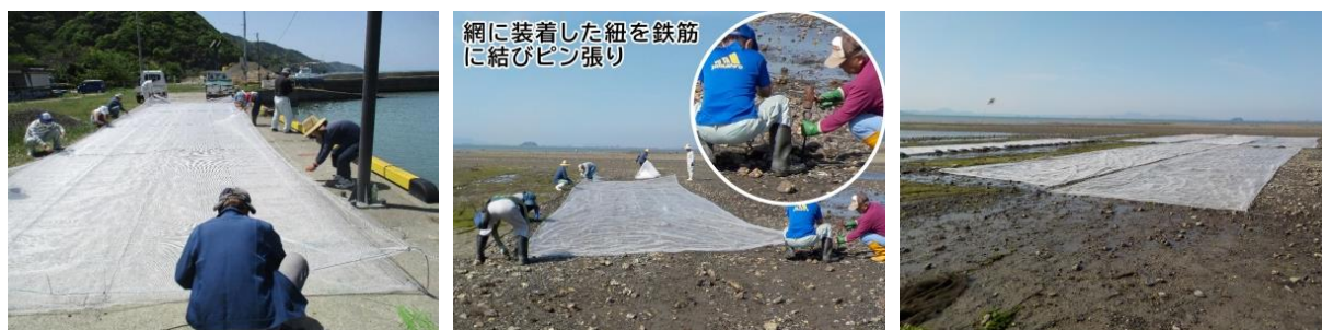
図7 被覆網の設置作業
