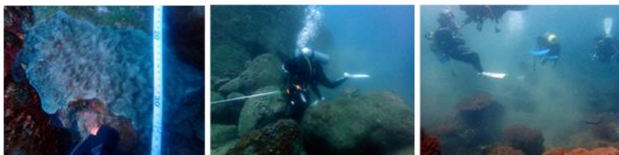
図6 モニタリングの作業状況
