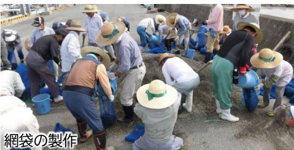
図7 網袋の製作・設置の作業状況
