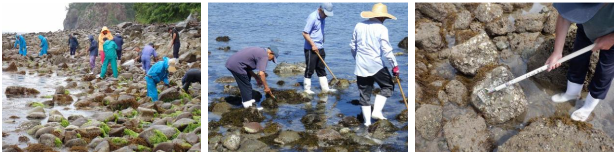
図6 岩盤清掃作業の状況
