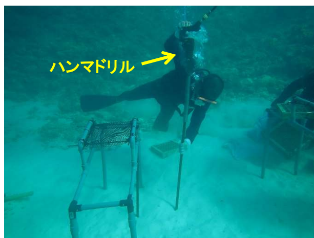
中間育成棚用の鉄筋の差し込み状況
