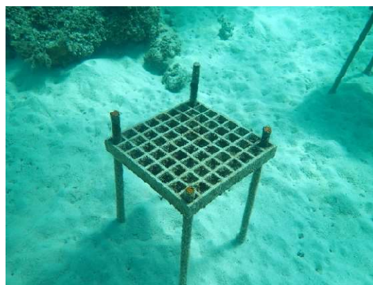
FRP 製グレーチング着床具用の 中間育成棚の設置状況
