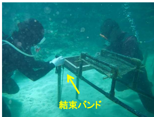
着床具の設置状況
