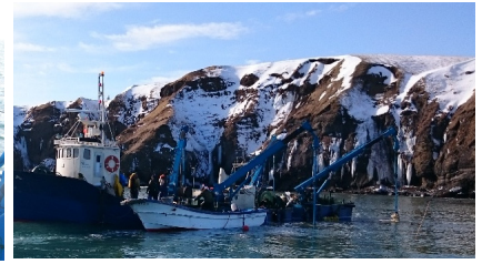
SK フープによる岩盤清掃作業
