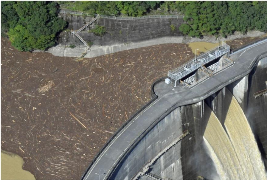
台風14号による大雨で上椎葉ダムに流れ込んだ大量の樹木＝宮崎県 椎葉村で2022年9月20日午後3時3分、本社ヘリから上入来尚撮影
