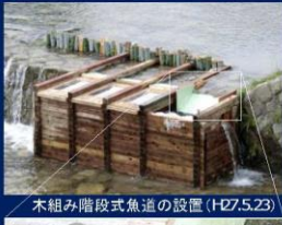
木組み階段式魚道の設置(H27.5.23)
