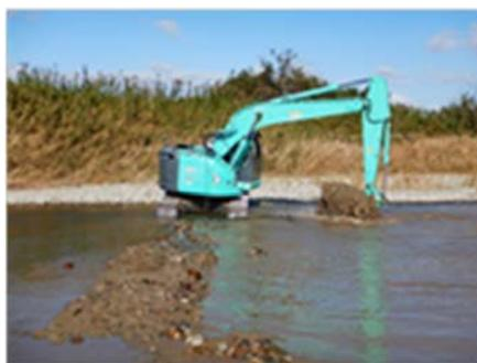
河床耕耘では、上流域から流出し、堆積した砂泥の除去による河道の整備や、河床の沈み石化が進んでいる瀬を掘り返すことにより生物の棲みやすい環境へ整備している。耕耘は重機を用いて行っており、人力では難しい作業も効率よく行っている。
