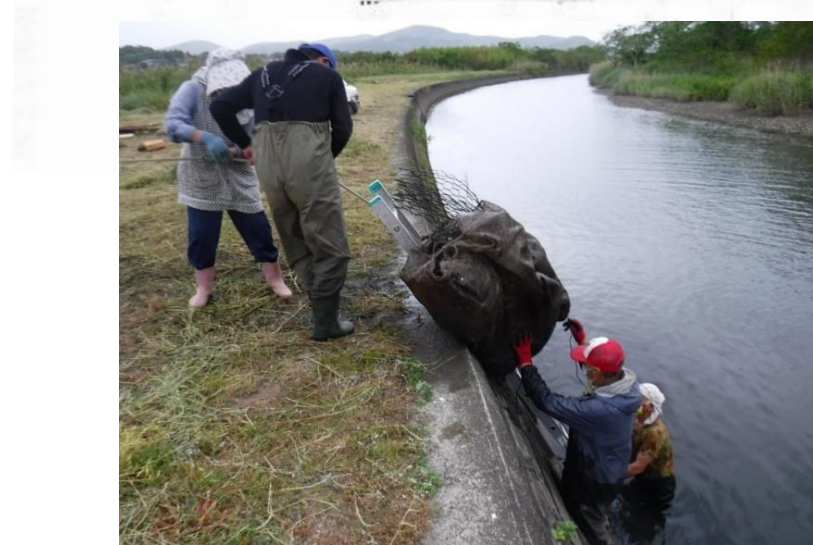
モニタリング 蛇籠引揚げ
