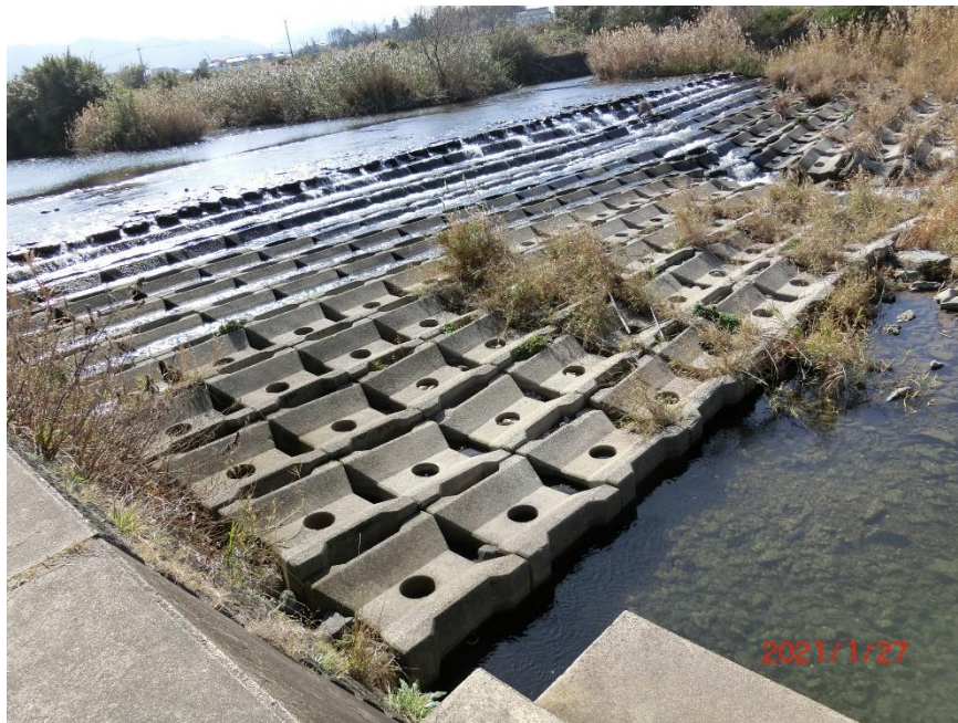
魚道のない段差工
