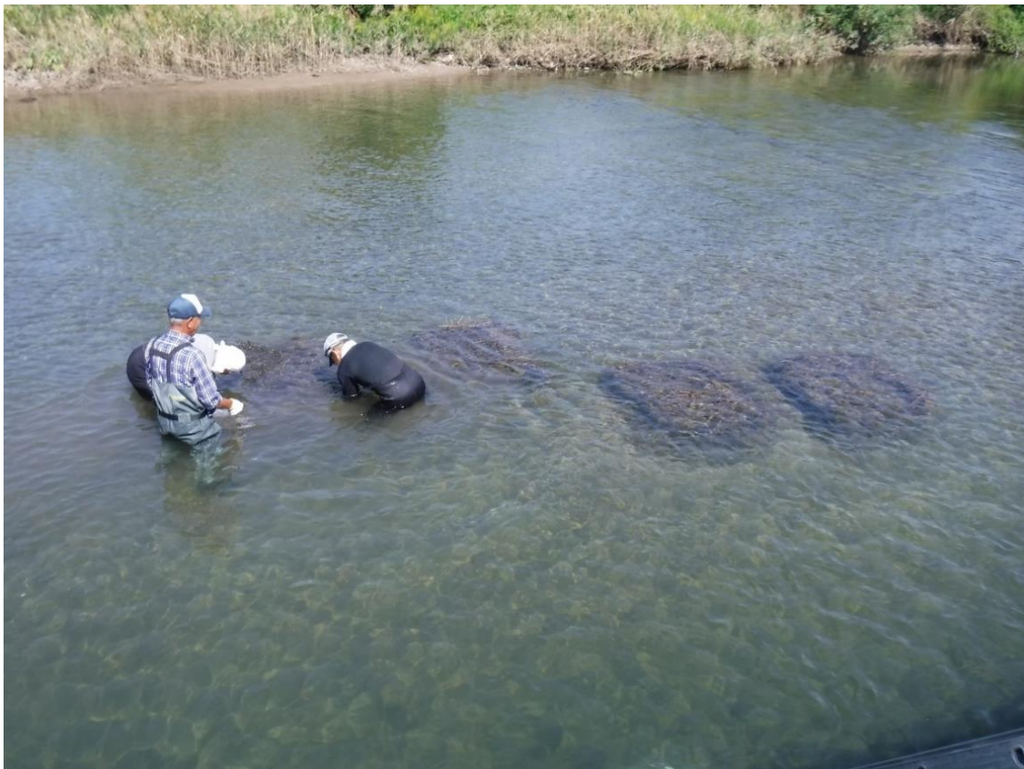
設置された石倉蛇籠
