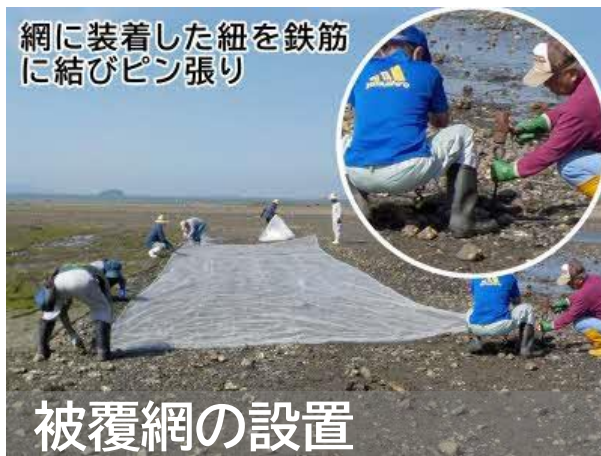
被覆網製作(筋縄取付)
