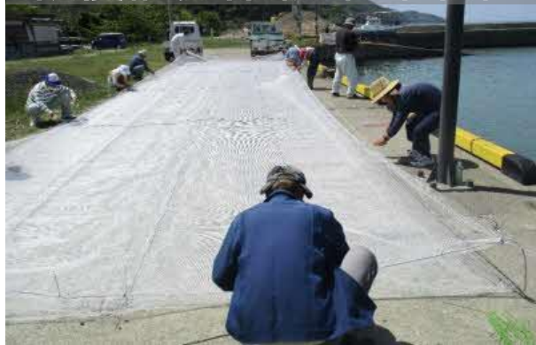
被覆網製作(筋縄取付)
