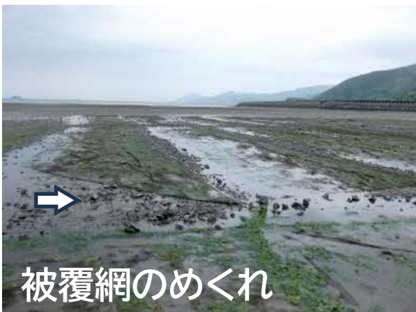
被覆網の破損
