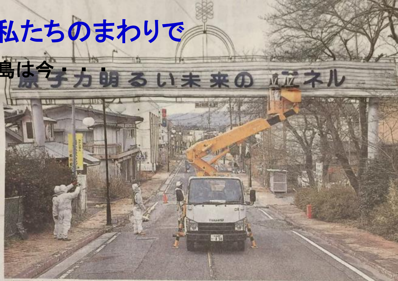
標語の文字パネルを作業員が取り外した＝21日午前10時48分、福島県双葉町、福留庸友撮影
