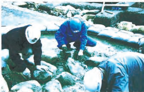
⑦粗石の間に20cm程の雑石を埋めながら、水路の側壁を作り、また、小階段状の小プールで水路をつなぐ。この工程だけは、生物の生態を良く知っている者（水産関係者等）にいっしょに作業をしてもらうことが望ましい。1日あれば作業は終わる。
