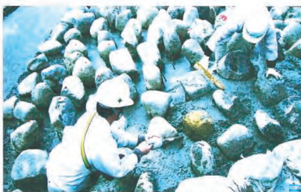
⑥粗石が半分ほど埋まる程度に、コンクリートを広げ、間詰めをする。
