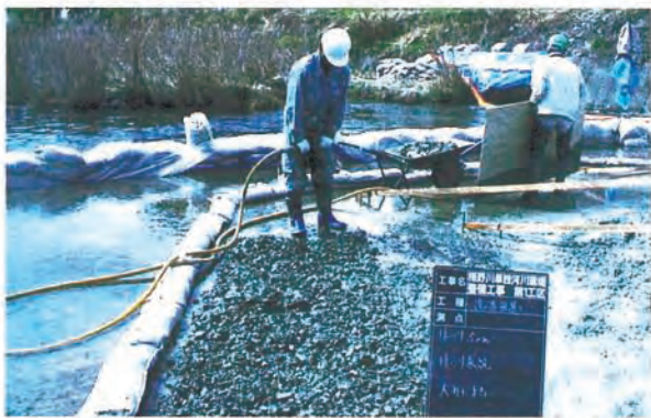
③可能であれば、魚道縁部の周囲を既設の構造物に影響のない範囲ではつり、周囲より深くする。ここでは5cm程はつった。
