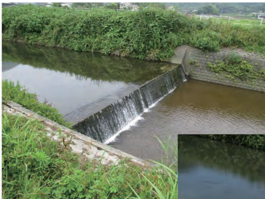
現況の堰(落差工)
