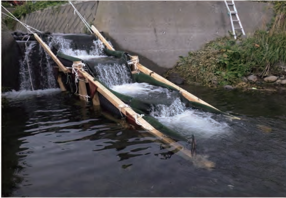
組立設置された魚道
