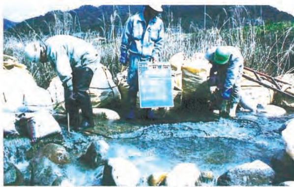
⑧魚道最上流部のプールへ水が滑らかに入るように、接続部をはつる。また、このときに流れの状態を確認し、必要であれば、プールから水路への流れ出し部分のコンクリートをはつり、流量を調整する。
