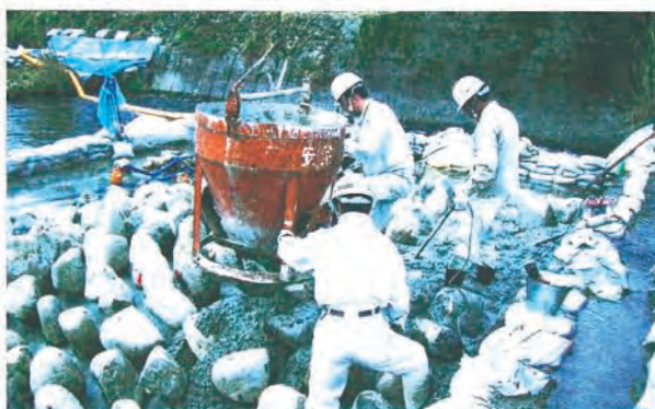
⑤二次コンクリートを打設する。
