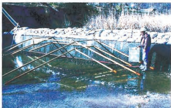
①魚道を据え付ける部分を洗浄し、 5分目 丁張りをする。この時点で、前方向・側方向とも勾配を1/5以下（可能であれば1/7程度）にしておくのが望ましい（この魚道は落差が小さく川幅が狭いため、側方向は1/3勾配として短くし、水路幅を広げることで流速を抑えた）。
