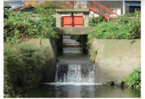
設置前の段差
