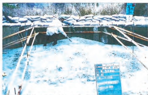
②差筋をした後に、一次コンクリートを打設する。
