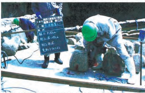
④一次コンクリートの養生を終えたら、30cm程度の粗石を置き、石の周囲2カ所にφ13mmで長さ200mm程度の差筋を10cmほど差し込んで固定する。粗石間の間隔は、20～30cm。
