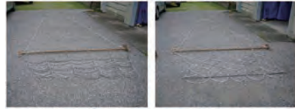
Aチェーン刈き器具(標準型)幅2.5m×長さ1.0m
