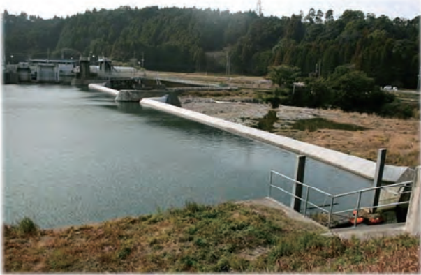
発電用取水堰
