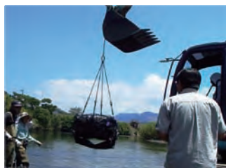
重機による設置作業
