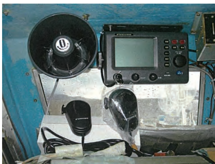
写真2 無線機器の設置(無線機等)
