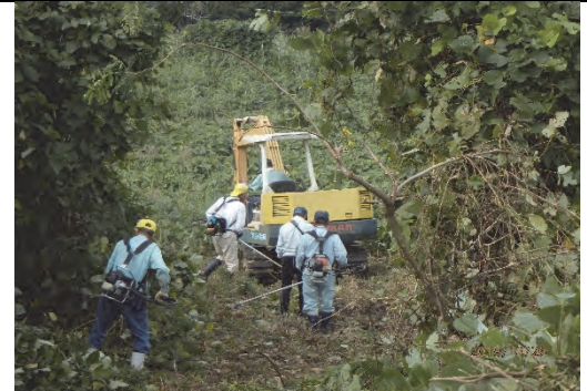
説明：産卵床整備・進入路整備
