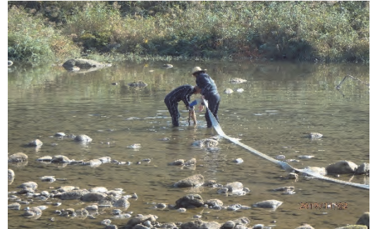
説明：産卵床整備・ポンプ作業
