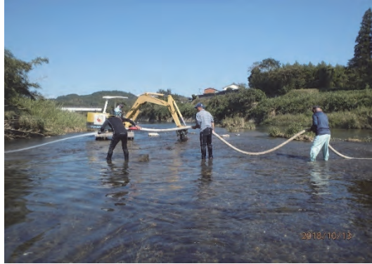
説明：産卵床整備・重機・ポンプ
