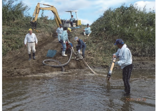
説明：産卵床整備・重機・ポンプ
