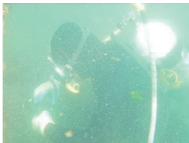
岩盤清掃の様子
