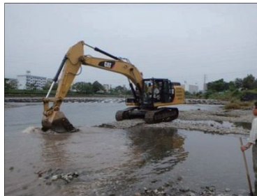
重機による河床整備
